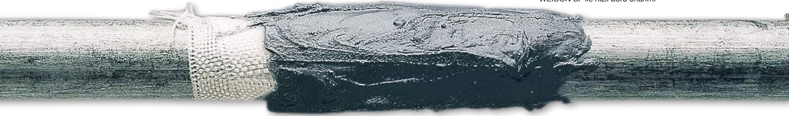
WEICON SF ile hızlı boru onarımı
